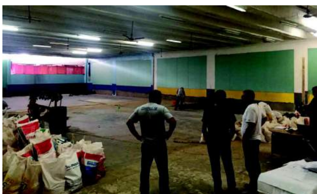
Vistoria do Comitê Olímpico Canadense (início das obras – Dezembro/2015)
