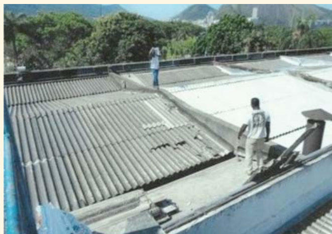
Colocação da Manta Aluminizada
