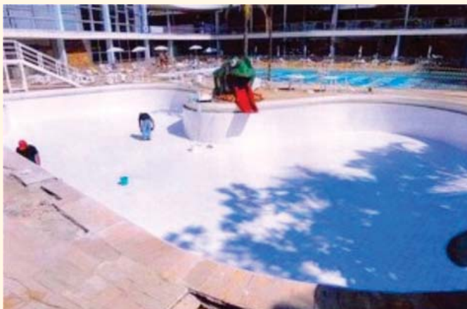
Retirada de vazamento
