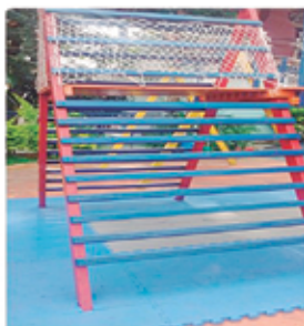
Colocação de ripas mais ripas de madeiras e troca da rede de proteção da casinha de madeira.
